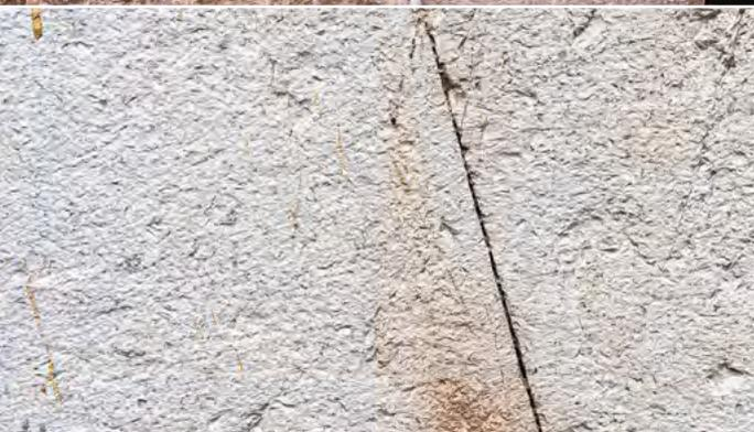
Il faut distinguer une façade en pierre de taille et une façade en moellons de pierre. La pierre de taille est découpée, sculptée et appareillée à joints fins pour être vue en façade ; c'est une surface noble et résistante aux intempéries (gel, pénétration d'eau, remontées de chlorures...).
