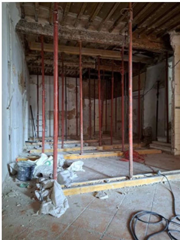
Etalement avant démarrage des travaux. 2022 12 22.
