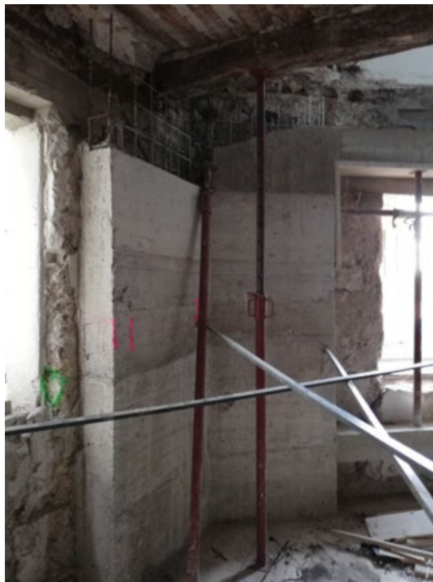
Travaux de reprise structurale. 2023 12 21.
